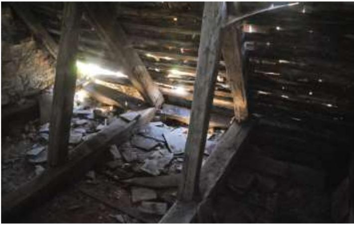
**Bild oben:** Beschädigte Deckenbalken
