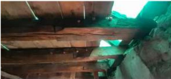
Reparatur Holzverbindung Deckenbalken
