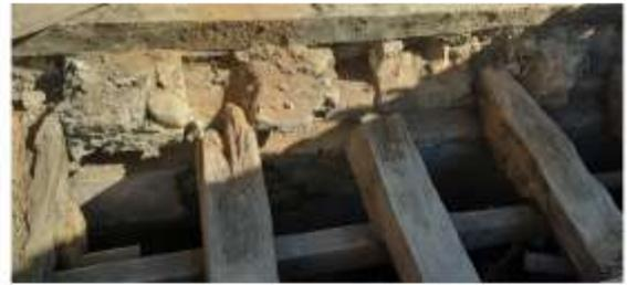
**Bild rechts:** Traditionelle Holzverbindung mit Altholz Ankerbalken
